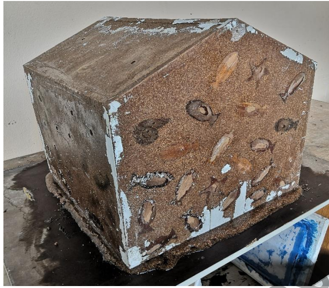
ภาพที่ 3.47 ผลงานการหล่อหลังจากที่นำแม่พิมพ์แผ่นไม้กระดานแยกชิ้นออกแล้ว ที่มา : บุษบา ผกากรอง, 22 เมษายน 2563
